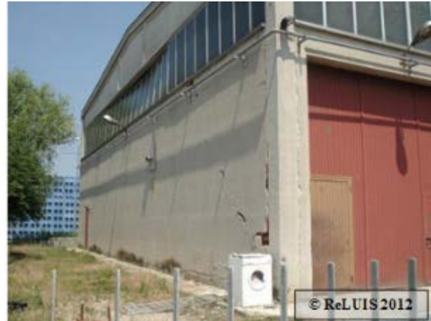
Figura 44 – Collasso e fessurazione del pannello di tamponatura in laterizio in una struttura prefabbricata monopiano di non recente costruzione
