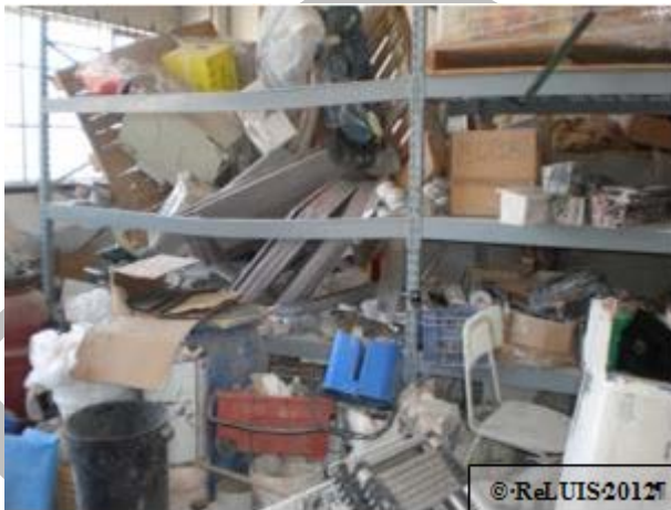
Figura 63 – Danneggiamento scaffalatura con conseguente perdita del materiale contenuto
