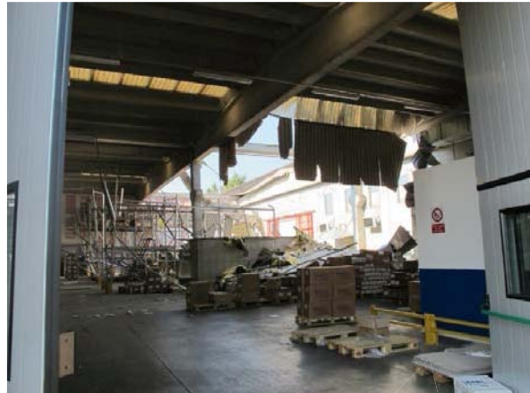
Figura 15 – Collasso della copertura per perdita di appoggio in un edificio monopiano prefabbricato con trave principale longitudinale
