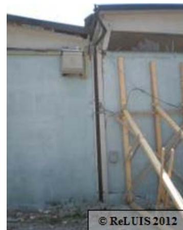
Figura 2 – Perdita di appoggio della trave principale a sezione variabile in un edificio monopiano prefabbricato con trave principale trasversale di non recente costruzione a causa della crisi a taglio del pilastro di appoggio, reso tozzo dalla configurazione del pannello di tamponatura
