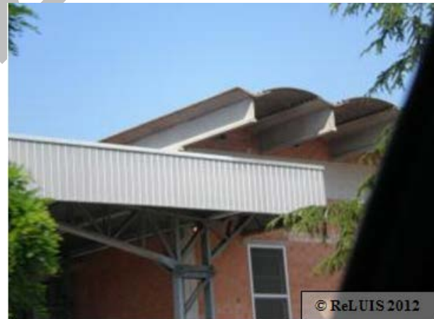
Figura 21 – Collasso della copertura con tegoli ad Y
