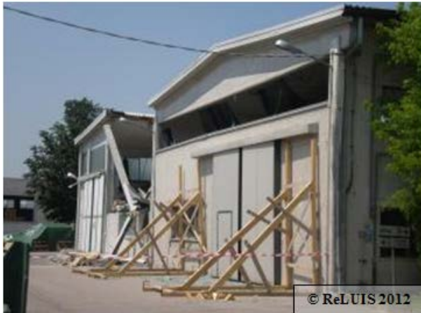
Figura 3 – Perdita di appoggio della trave principale in un edificio monopiano prefabbricato con trave principale trasversale costruito recentemente in ampliamento di un edificio esistente con connessione trave-pilastro attritiva
