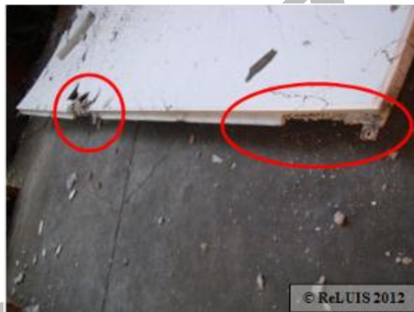
Figura 20 – Collasso di una lastrina di copertura in un edificio monopiano prefabbricato con trave principale longitudinale
