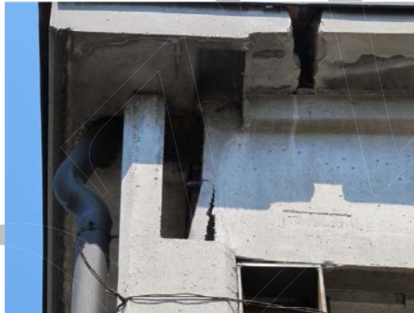
Figura 10 - Perdita quasi completa dell'appoggio della trave
