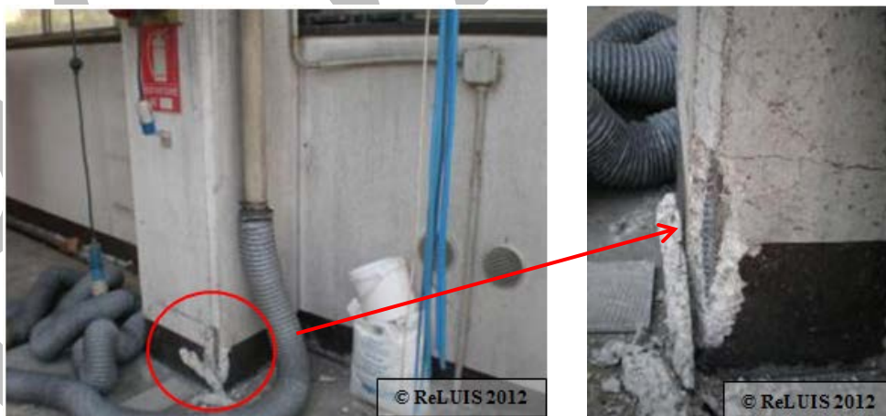
Figura 57 - Fessurazione alla base dei pilastri di un edificio monopiano prefabbricato
