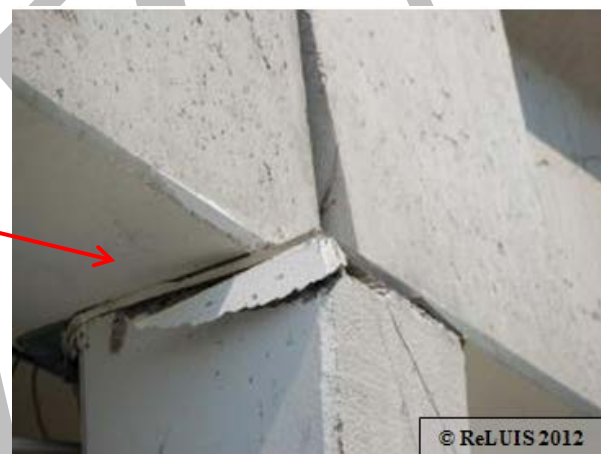
Figura 18 – Inadeguatezza del vincolo trave-colonna con danneggiamenti locali del pilastro e rotazioni permanenti della trave in copertura
