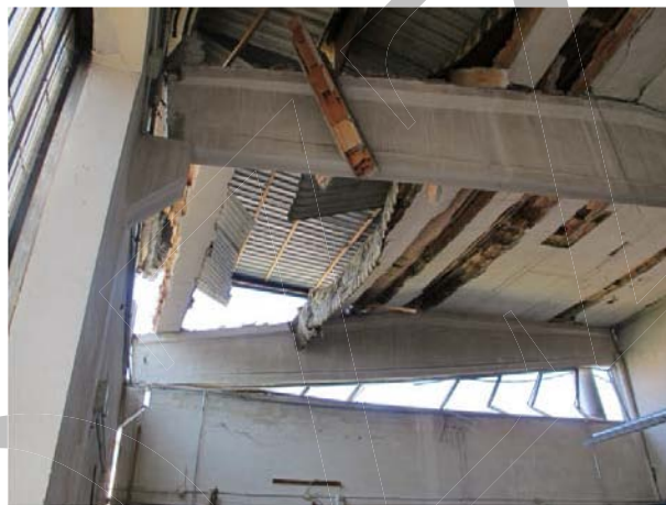
Figura 7 - Perdita di appoggio della trave in un edificio monopiano prefabbricato con trave principale trasversale
