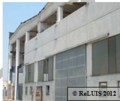
Figura 27 – Collasso pannelli orizzontali di tamponamento in strutture monopiano prefabbricate
