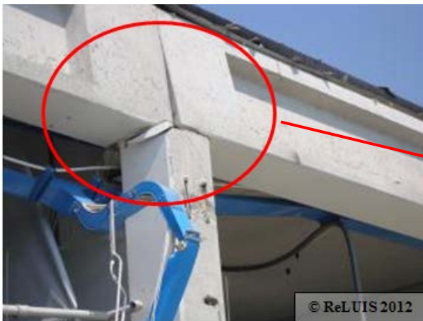
Figura 18 – Inadeguatezza del vincolo trave-colonna con danneggiamenti locali del pilastro e rotazioni permanenti della trave in copertura
