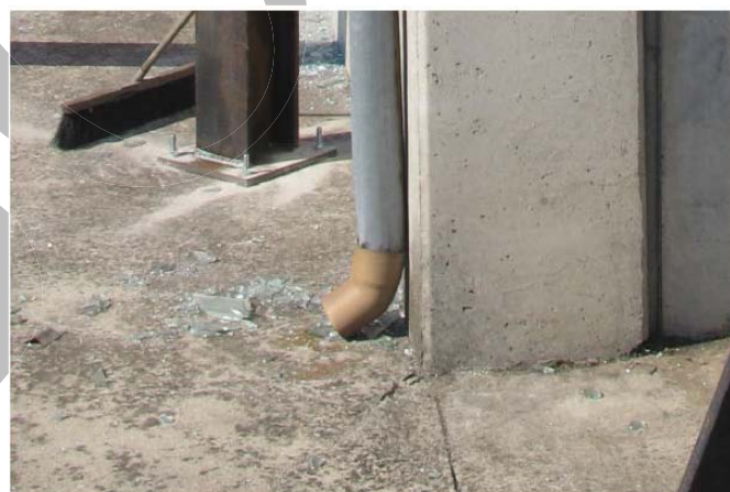
Figura 55 – Rotazione alla base del pilastro
