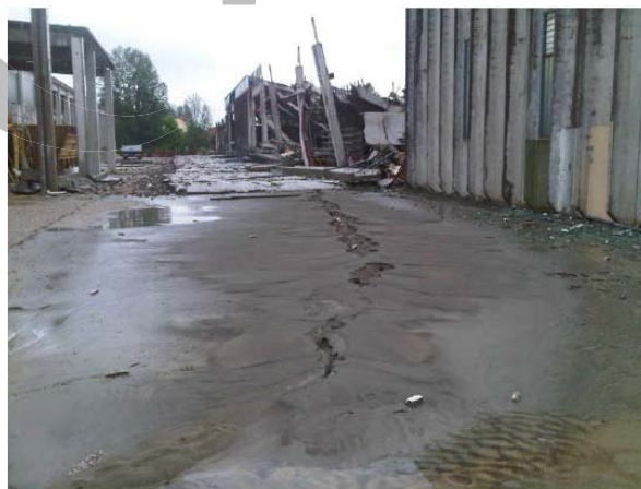
Figura 52 - Collasso dovuto alla rotazione dei pilastri in fondazione causata da fenomeni di liquefazione
