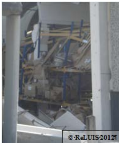
Figura 65 – Collasso scaffalature e conseguente perdita di contenuto
