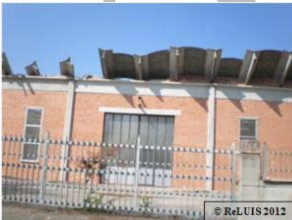
Figura 21 – Collasso della copertura con tegoli ad Y
