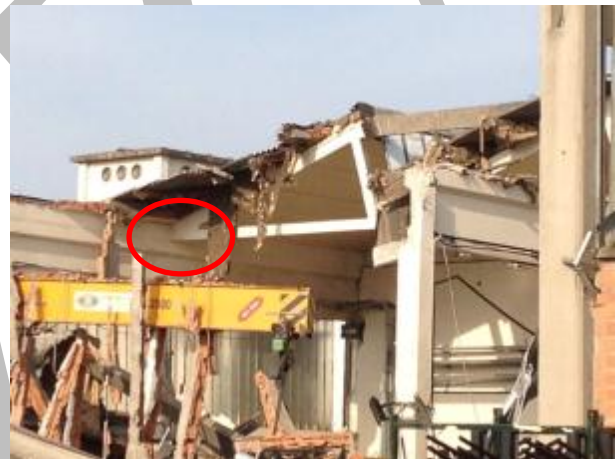
Figura 15 – Collasso della copertura per perdita di appoggio in un edificio monopiano prefabbricato con trave principale longitudinale
