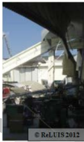
Figura 12 - Perdita di appoggio della trave per rottura connessione in un edificio con trave principale trasversale
