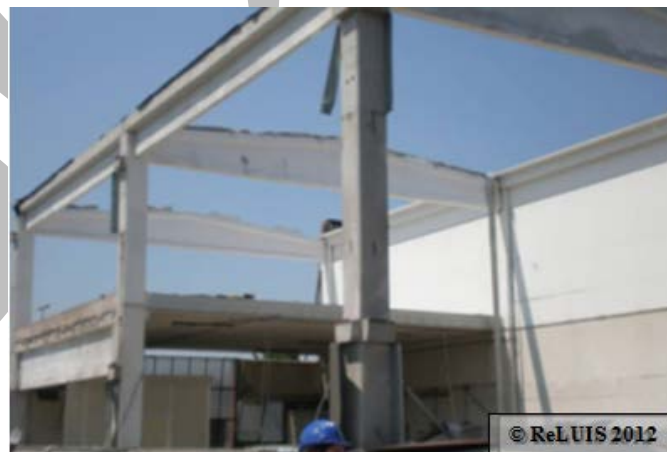
Figura 14 - Collasso dei tegoli di copertura per perdita di appoggio in un edificio prefabbricato con trave principale trasversale
