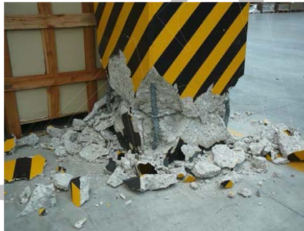
Figura 60 - Cerniera plastica alla base del pilastro
