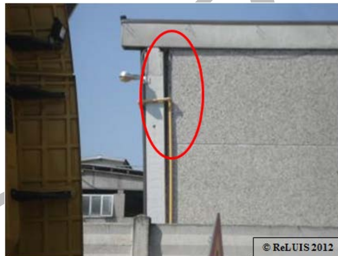
Figura 51 – Perdita di verticalità del pilastro
