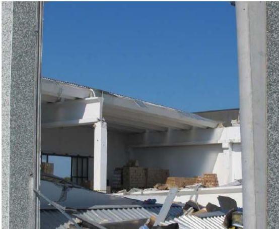
Figura 12 - Perdita di appoggio della trave per rottura connessione in un edificio con trave principale trasversale
