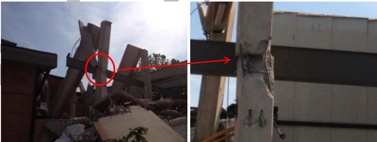
Figura 61 – Formazione cerniera plastica in corrispondenza della mensola tozza, appoggio della trave porta-carroponte
