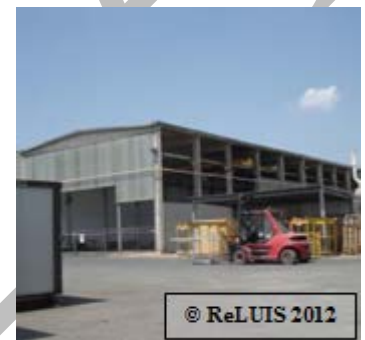
Figura 27 – Collasso pannelli orizzontali di tamponamento in strutture monopiano prefabbricate
