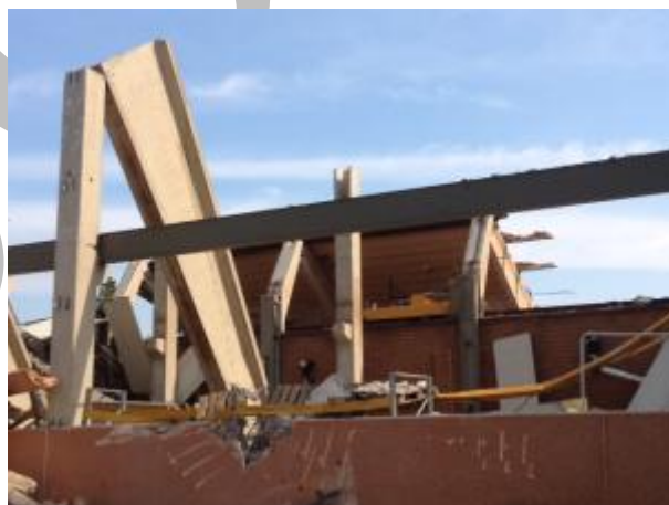
Figura 5 – Perdita di appoggio della trave principale in un edificio monopiano prefabbricato con trave principale trasversale
