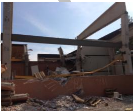
Figura 34 – (a e b) Crollo di pannelli orizzontali di tamponamento in un edificio monopiano prefabbricato e (b) dettaglio profili a C in corrispondenza del pilastro
