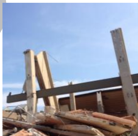
Figura 34 – (a e b) Crollo di pannelli orizzontali di tamponamento in un edificio monopiano prefabbricato e (b) dettaglio profili a C in corrispondenza del pilastro
