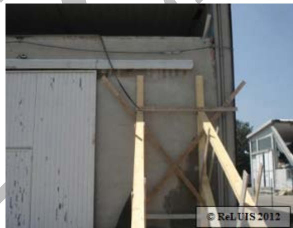
Figura 45 - Collasso incipiente per meccanismo fuori dal piano dei pannelli in laterizio in una struttura prefabbricata monopiano di non recente costruzione
