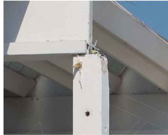
Figura 12 - Perdita di appoggio della trave per rottura connessione in un edificio con trave principale trasversale
