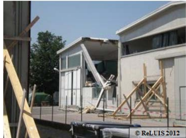
Figura 3 – Perdita di appoggio della trave principale in un edificio monopiano prefabbricato con trave principale trasversale costruito recentemente in ampliamento di un edificio esistente con connessione trave-pilastro attritiva
