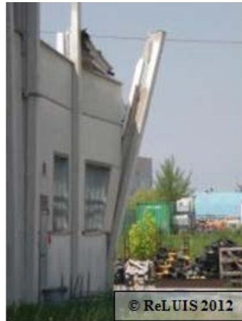
Figura 50 – Perdita di verticalità del pilastro per rottura alla base per cause non accertabili
