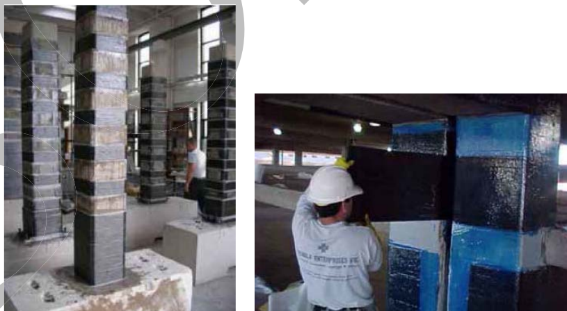
Figura 89 – Fasciatura di pilastro in FRP
