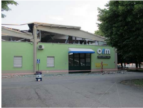
Figura 9 - Perdita di appoggio delle travi in un edificio monopiano prefabbricato con trave principale trasversale
