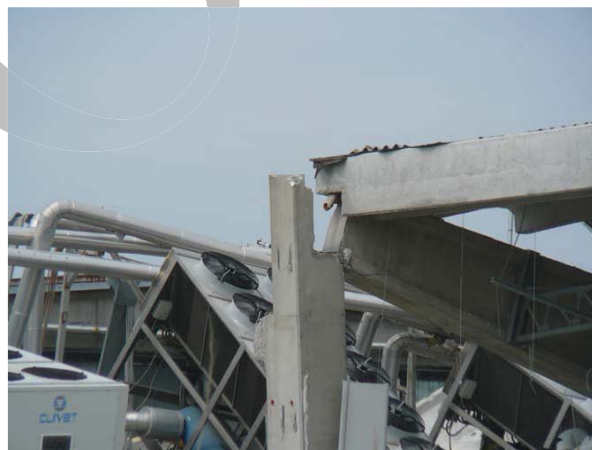
Figura 17 - Collasso capriata per perdita di appoggio
